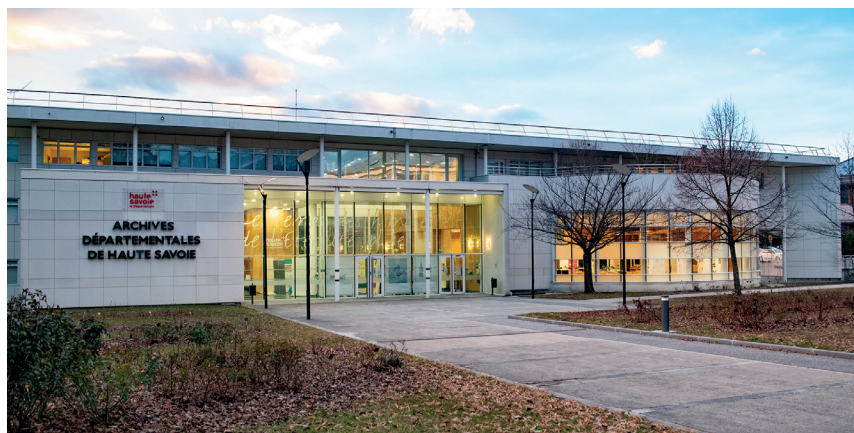
Bâtiment des Archives Départementales © Conseil Départemental
